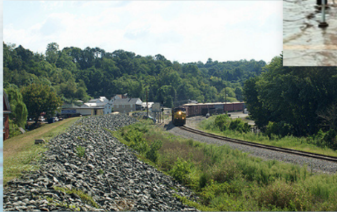
Levee, Scottsville, VA
